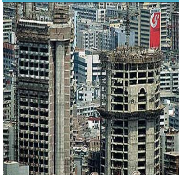
图六: 基础设施的建设, 带动了中国经济
